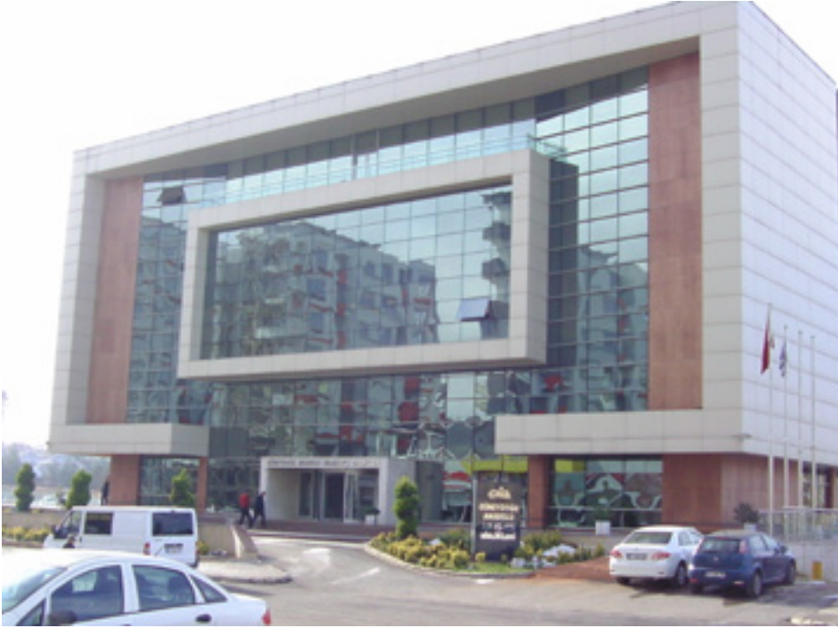
Şekil 15. GAİB Hizmet Binası
