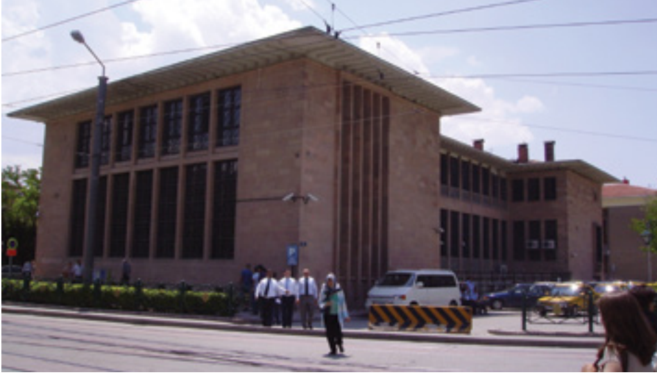
Şekil 8: Eskişehir Merkez Bankası arka cephe
