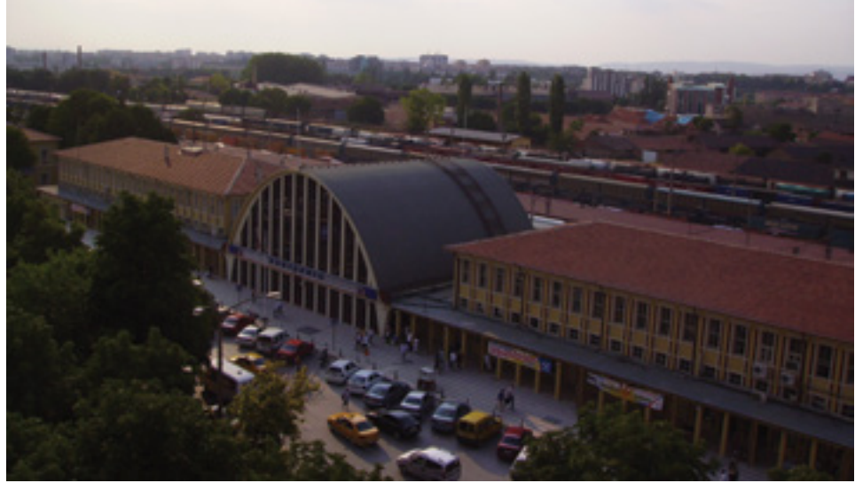
Şekil 5: Mevcut Gar Binası
